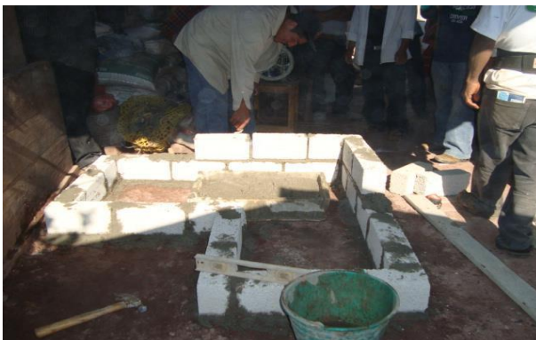
Trazo, construcción de las hornillas y puesta del comal.
